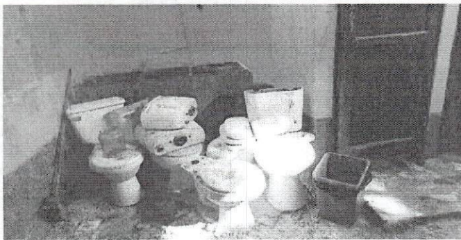
Foto1: Cambio de Inodoros
