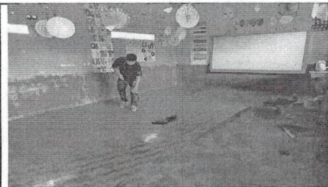
Foto 3: Cambio de Piso Cerámico Aula 2
